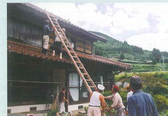
7月 雨樋の詰まりを取っています
